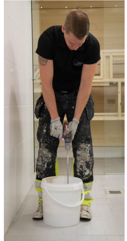
Sekoita Gripin A-osa ennen käyttöä
