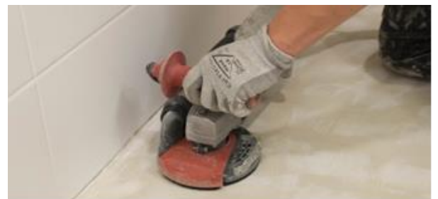
Pohjalaastin pinta hiotaan jatkuvakehäisellä timanttikuppilaikalla
