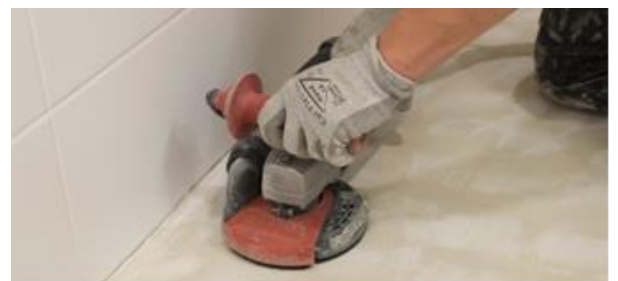
Pohjalaastin pinta hiotaan jatkuvakehäisellä timanttikuppilaikalla
