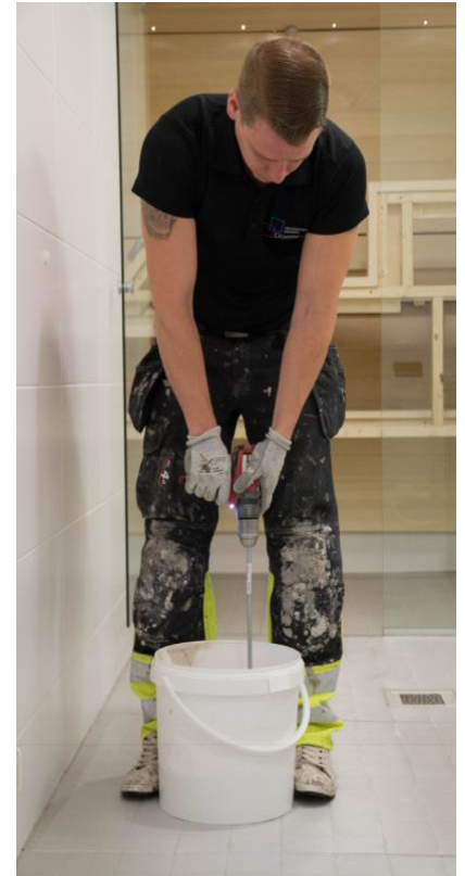
Sekoita Base 2K:n A-osa ennen käyttöä
