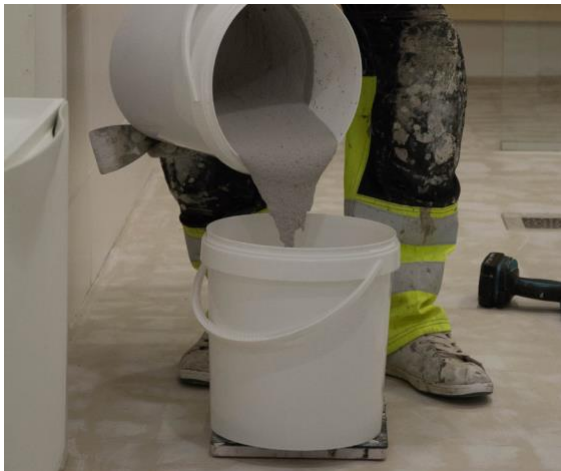
beton on sävytetty, keskikarkea ja todella kova 2-komponenttinen laasti.
