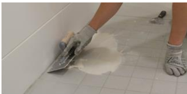
Pohjalaastin levitys tapahtuu Dekofloor pohjalaastilastalla
