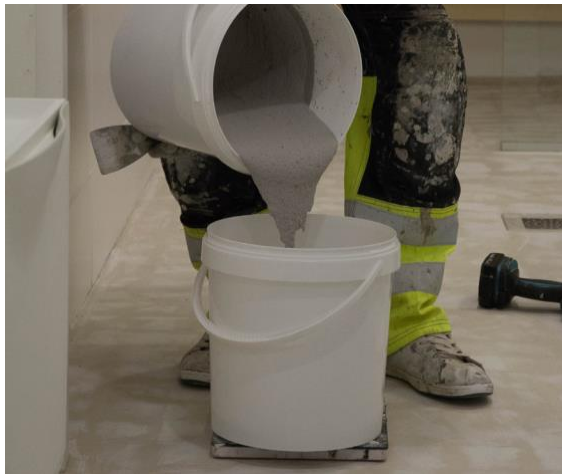
stucco on sävytetty, hienojakoinen ja todella kova 2-komponenttinen laasti.
