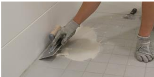
Pohjalaastin levitys tapahtuu Dekofloor pohjalaastilastalla
